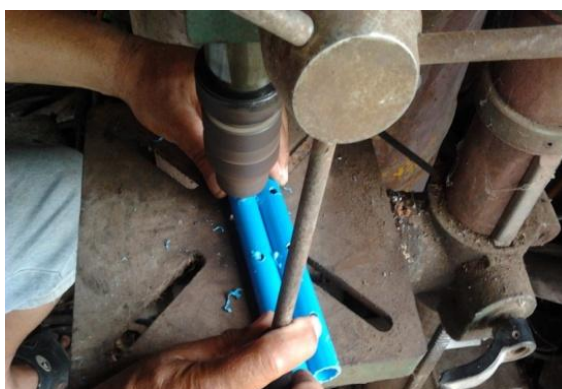
ภาพประกอบที่ 4.19 แสดงการเจาะรูท่อกระจายน้ำเสีย
