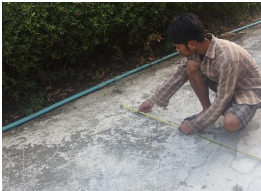
ภาพประกอบที่ 4.2 แสดงการวัดขนาดพื้นที่ในการสร้างบ่อทดลอง
