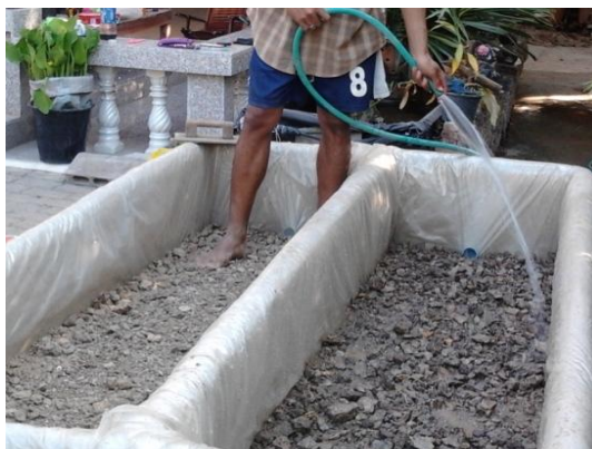
ภาพประกอบที่ 4.11 ชั้นดินในระบบบึงประดิษฐ์
