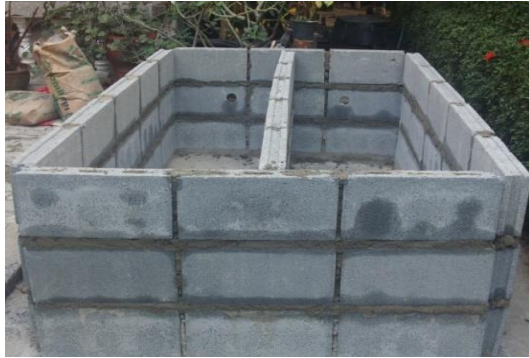
ภาพประกอบที่ 4.4 บ่อทดลองก่อด้วยอิฐบล็อก
