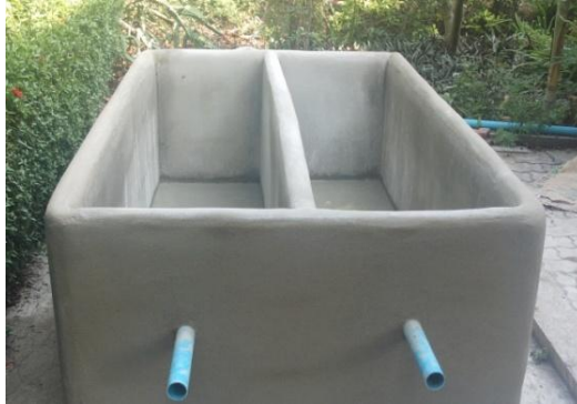
ภาพประกอบที่ 4.7 บ่อทดลองก่อด้วยอิฐรูปสี่เหลี่ยมฉาบปูน
