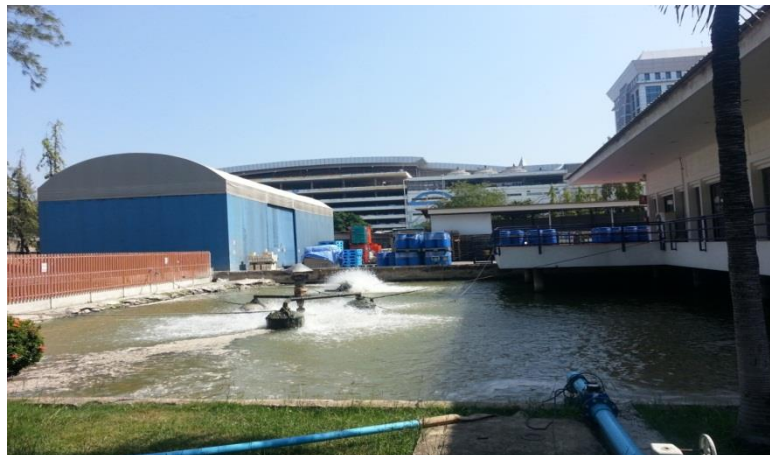
ภาพประกอบที่ 2.20 บ่อพักน้ำที่ผ่านการบำบัด ก่อนปล่อยออกสู่คลองเปรมประชากร
